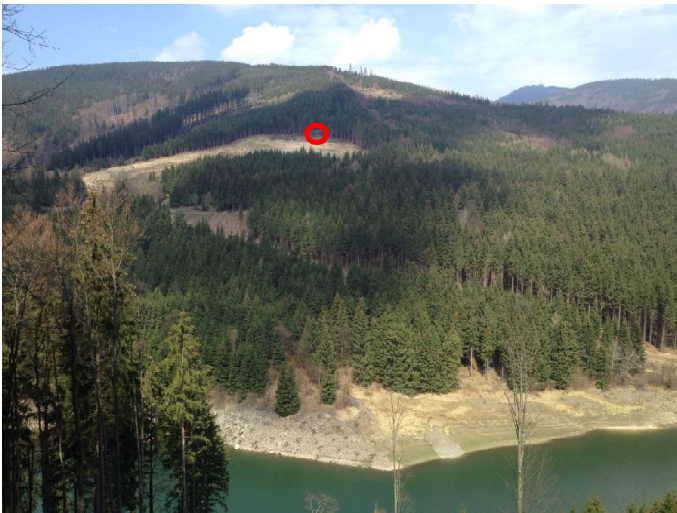
Obr.1 - Umístění vrtu v prostoru nad horním okrajem těžby sesuvu (červené kolečko)
