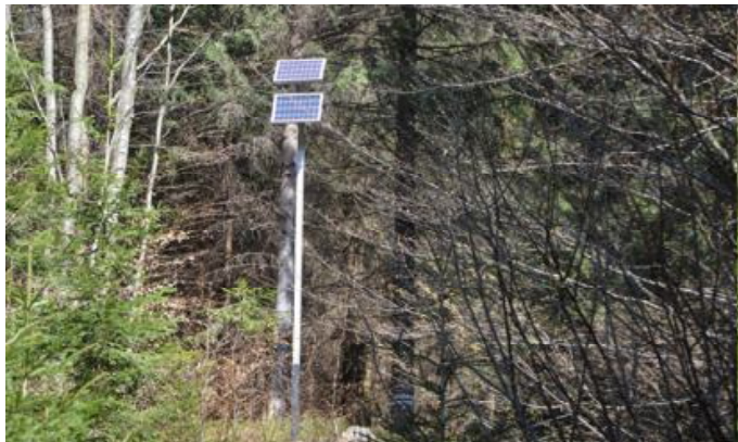
Obr.4 - Napájení systému fotovoltaickým panelem
