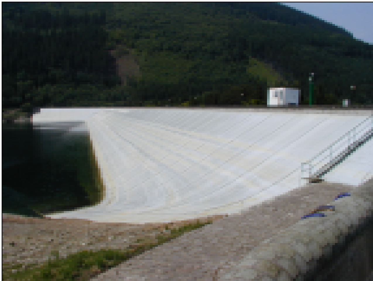
VD Morávka s novým těsněním návodního pláště
