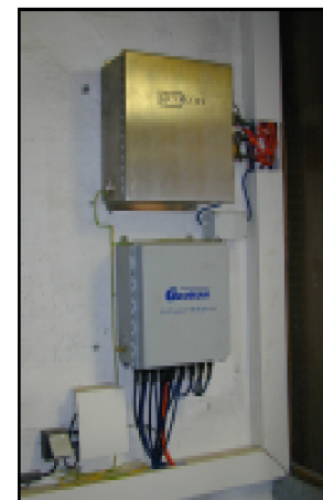
1 multikanálový datalogger Micro-10 a 1 multiplexer
